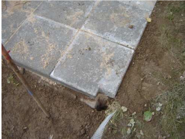
Abb. 2: Bodenplatte mit ausgeklinkter Ecke für Einschlaghülse.
