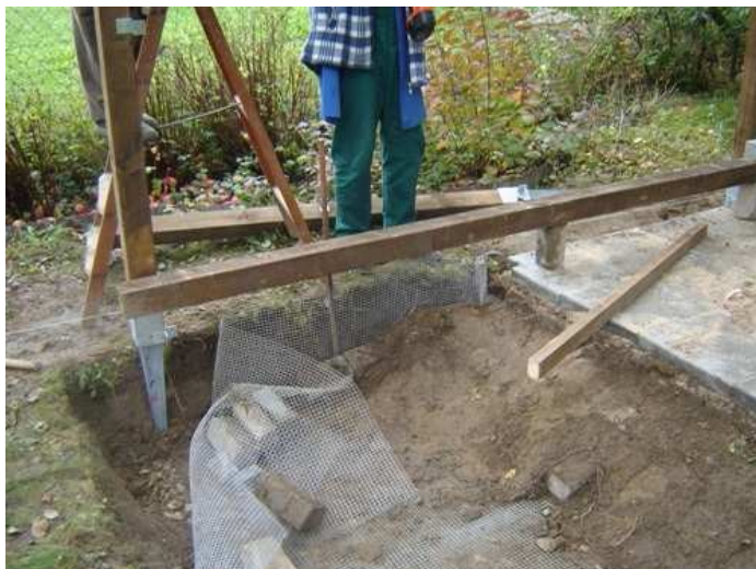
Abb. 3: Boden mit einer Einschlaghülse und erster Querbalken von Rahmenkonstruktion in einer Hülse. Der Balken liegt noch leicht schräg, da die mittlere Einschlaghülse noch fehlt.
