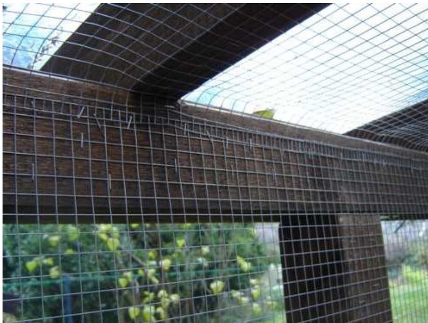
Abb. 4: Verbindung des Volierendrahtes an der Decke mit den Seitenteilen. Zwischenräume wurden vermieden. Denn es gilt die Regel: wo ein Hühnerei durchpasst, kommt auch ein Marder durch.
